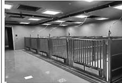
Pig Fan Cage System
